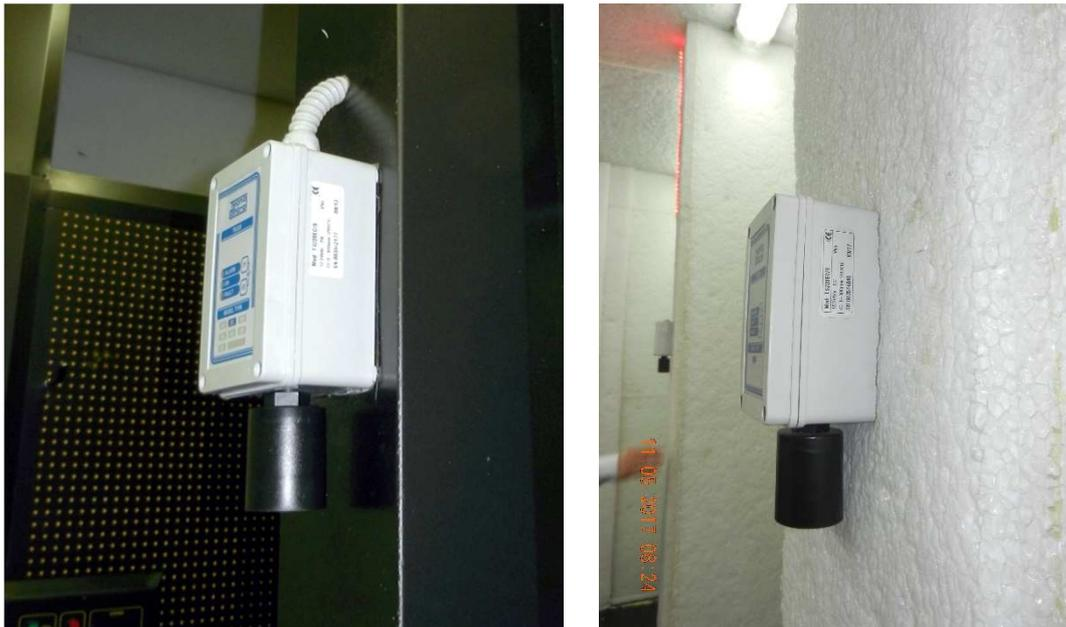
Figura 51 – Sensore di rilevazione del monossido di carbonio installato sul soffitto di separazione/muro laterale
