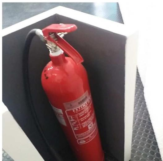
Figura 19a – Esempio tipo di protezione di un estintore per poligoni di 1ª e 2ª categoria
