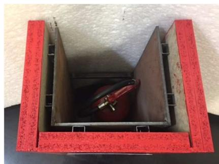
Figura 19b – Esempio tipo di protezione di un estintore per poligoni di 3ª categoria
