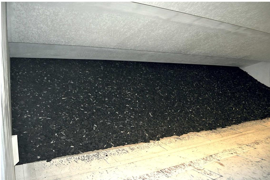
Figura 44 – Frontale di un particolare parapalle ad assorbimento
